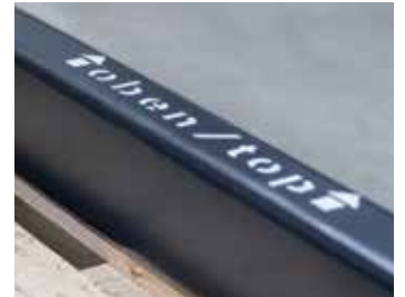
Indicación del sentido correcto de montaje
